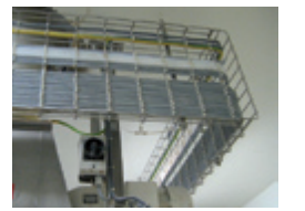
Cablofil wire mesh cable tray
